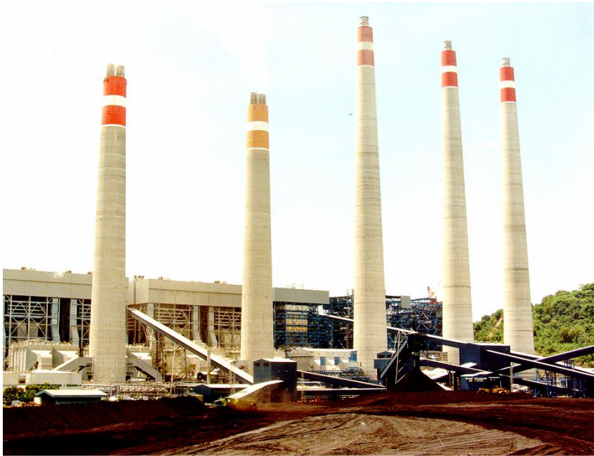
Coal Yard PLTU Suralaya 4 x 400 MW dan 3 x 600 MW di Jawa Barat dimana tampak Conveyor Pengangkut Batu Bara dan Cerobong.
