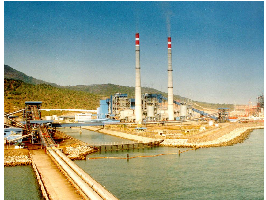
PLTU Paiton milik PLN 2 x 400 MW di Jawa Timur dimana tampak Intake Air, Conveyor Batu Bara, Ketel Uap, dan Cerobong.
